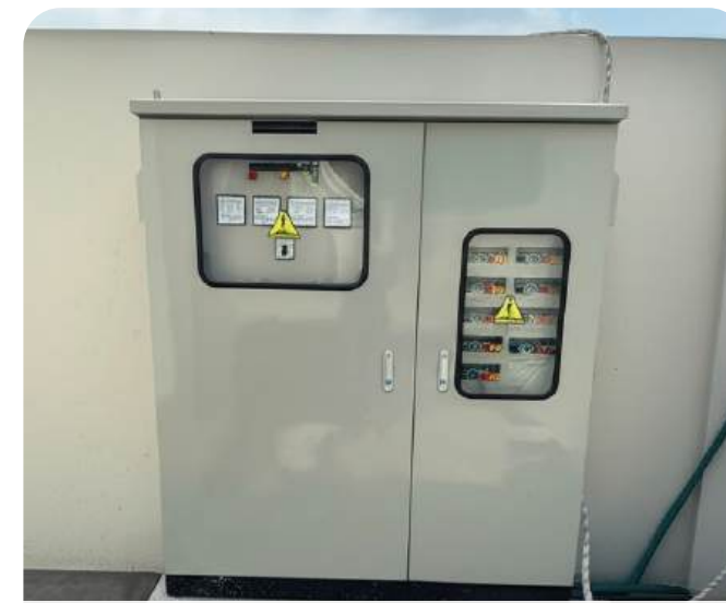
Thi công Tủ điện
