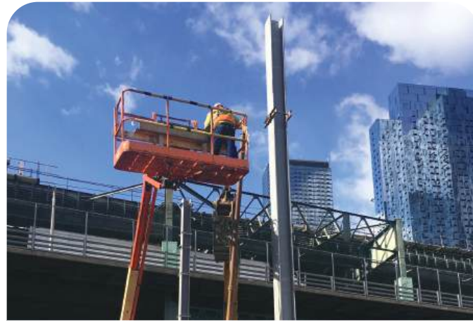
Thi công hệ thống chiếu sáng
