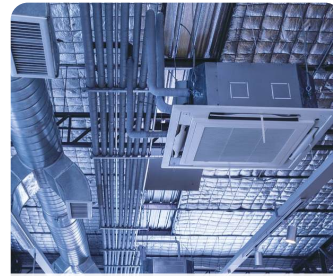
Thi công Điều hoà Thông gió
