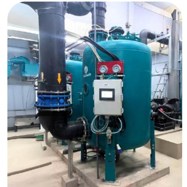
Hình ảnh bộ lọc Perlite Aquaswift Lắp đặt tại Công viên nước Sun World Hà Nam
