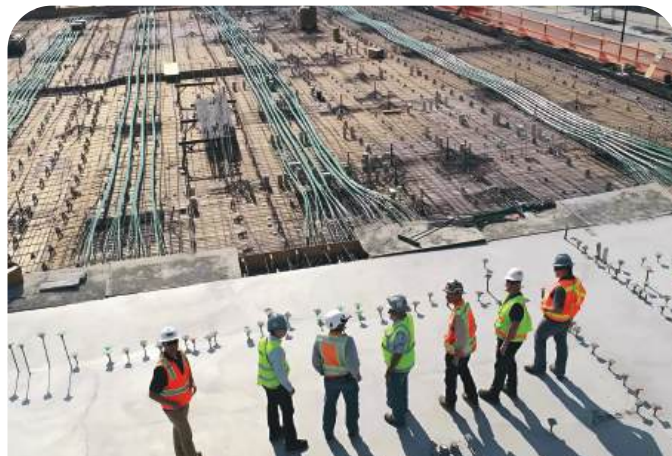
Thi công cơ điện ngoài trời
