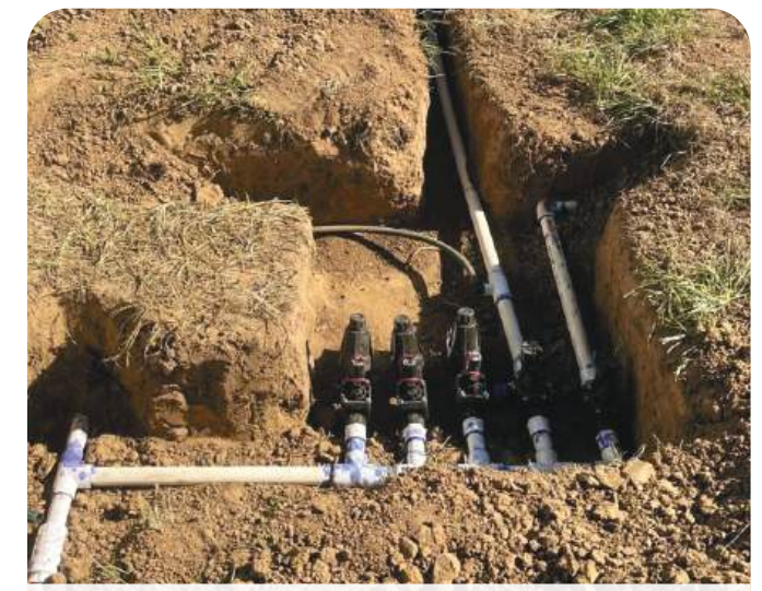
Thi công hệ thống tưới tự động
