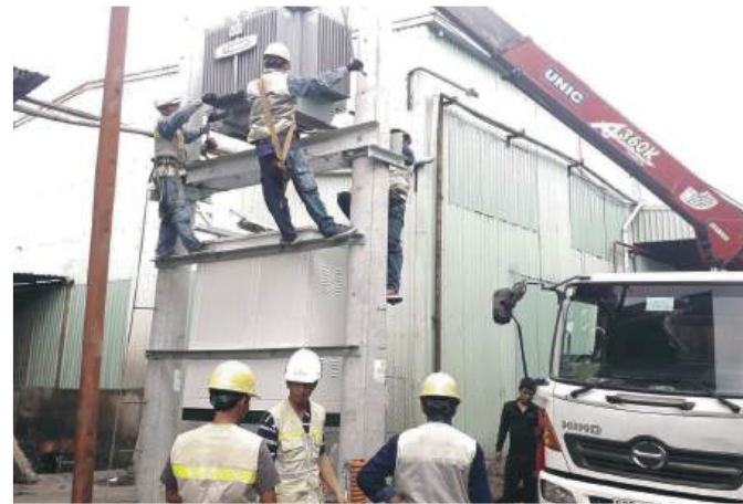
Thi công trạm điện
