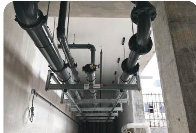
Thi công hệ thống thoát nước
