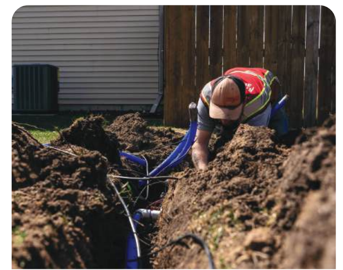
Thi công Hệ thống Tưới tự động
