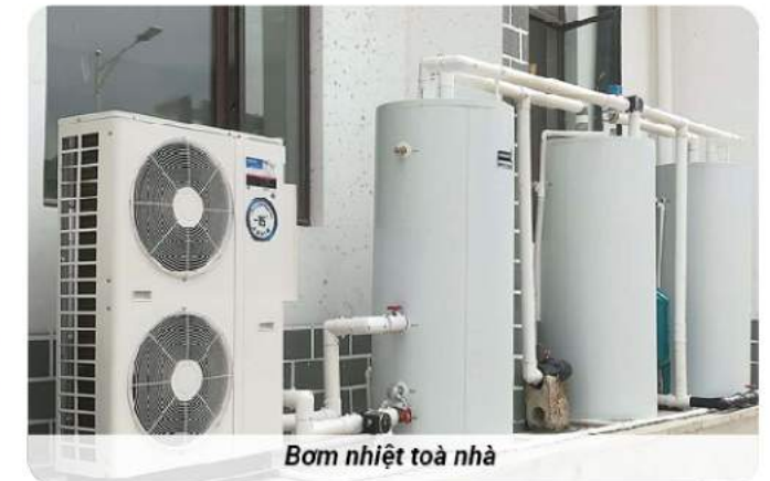
Hệ thống bơm nhiệt bể bơi bốn mùa
