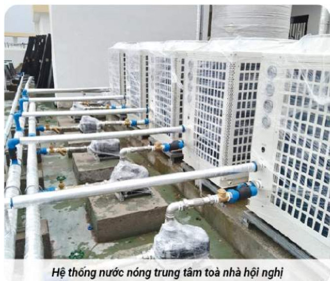
Hệ thống bơm nhiệt nước nóng khách sạn TTP Quảng Ninh
